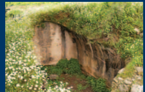
Η δεξαμενή The cistern
