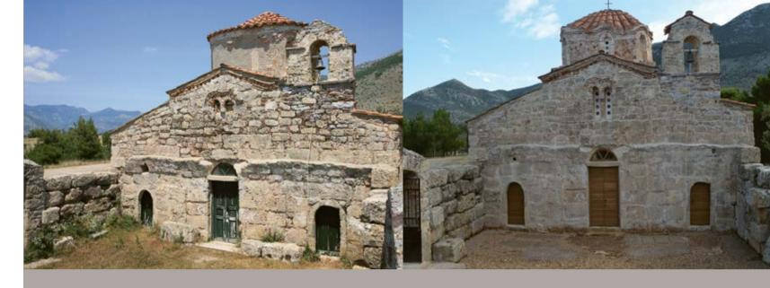
Στο πλαίσιο του έργου πραγματοποιήθηκαν: συντήρηση του συνόλου των τοιχογραφιών και του γλυπτού διακόσμου, εξυγίανση θολοδομίας με αποκατάσταση του τρούλου, τοπικές εργασίες εξυγίανσης της υπόλοιπης στέγης και αποκατάστασης του ναού, όπου κρίθηκε απαραίτητο. Τέλος, αντικαταστάθηκαν τα κουφώματα και πραγματοποιήθηκαν εργασίες διαμόρφωσης στον περιβάλλοντα χώρο του μνημείου.
