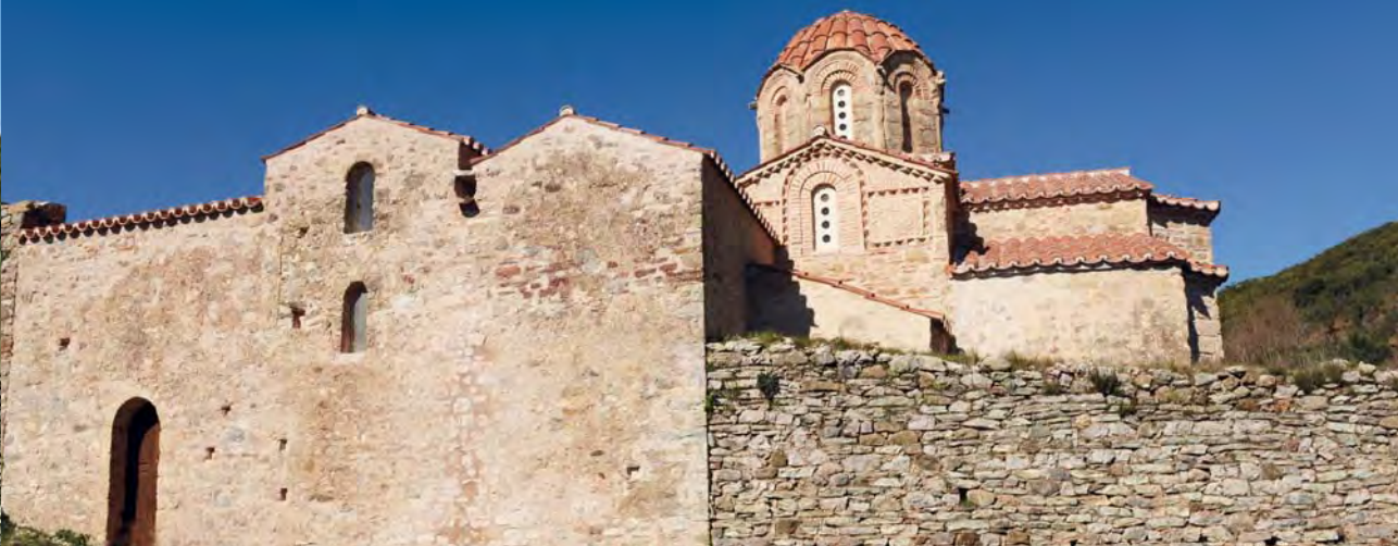
Νότια όψη του καθολικού πριν και μετά τις εργασίες αποκατάστασης The south façade of the katholikon before and after the restoration
