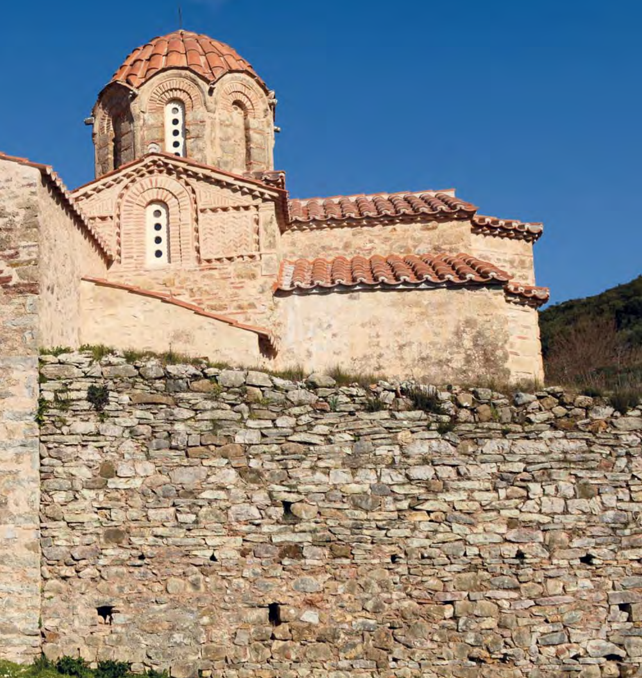
Νότια όψη του καθολικού μετά την ολοκλήρωση των εργασιών αποκατάστασης Katholikon, view from the south after the restoration
