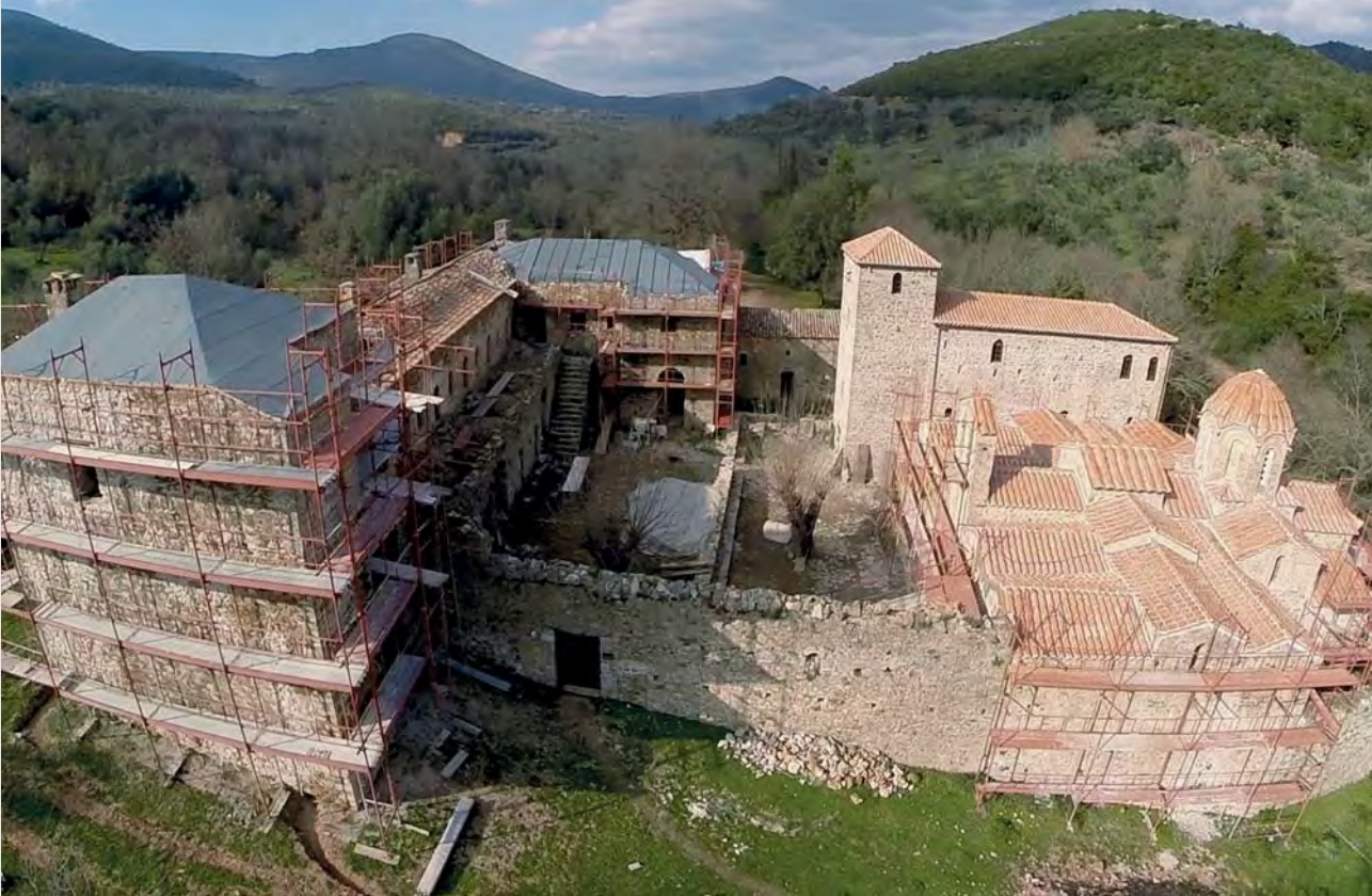
Αεροφωτογραφία της μονής κατά τη διάρκεια των εργασιών (2014) Aerial view of the monastery during the restoration (2014)
