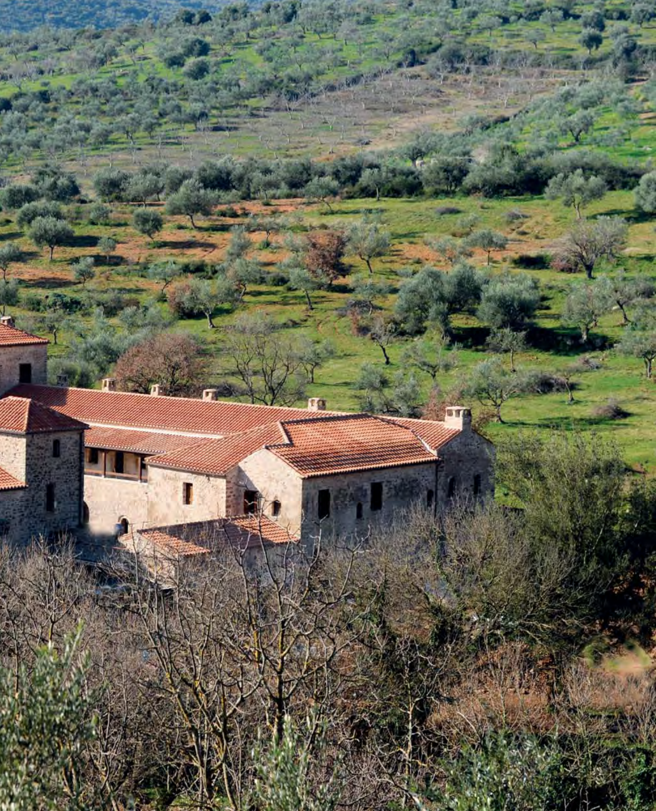
Γενική άποψη της μονής μετά την ολοκλήρωση των αναστηλωτικών εργασιών General view of the monastery after the restoration
