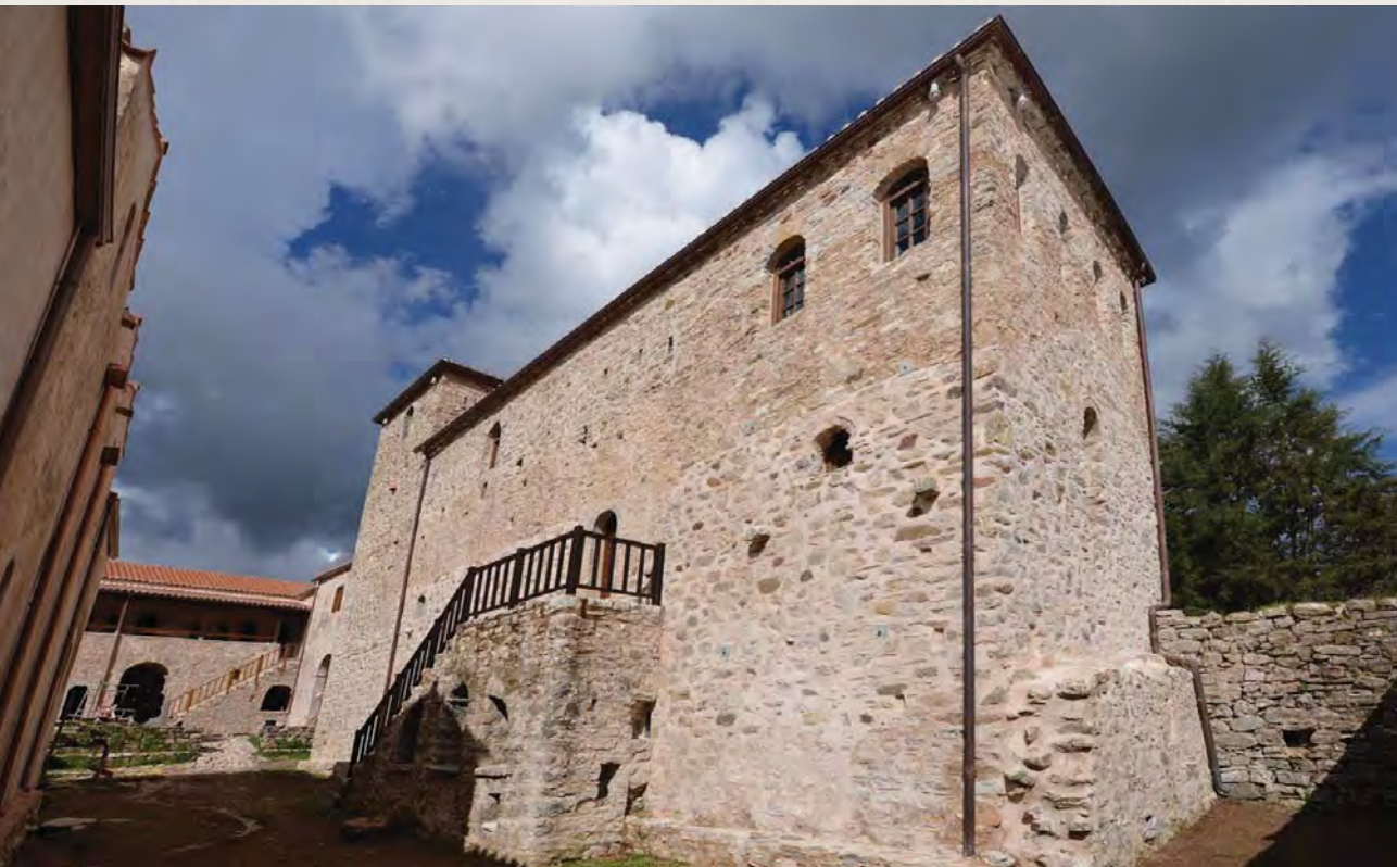
Η τράπεζα της μονής πριν και μετά την ολοκλήρωση των εργασιών αποκατάστασης The refectory of the monastery before and after the restoration
