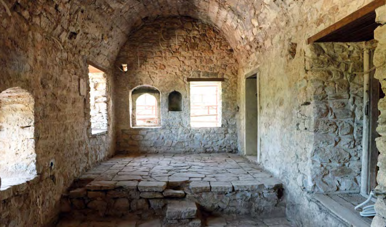
Εσωτερική άποψη του μεγάλου δωματίου στον όροφο της βορειοδυτικής πτέρυγας Interior view of the largest room at the second level of the northwest wing
