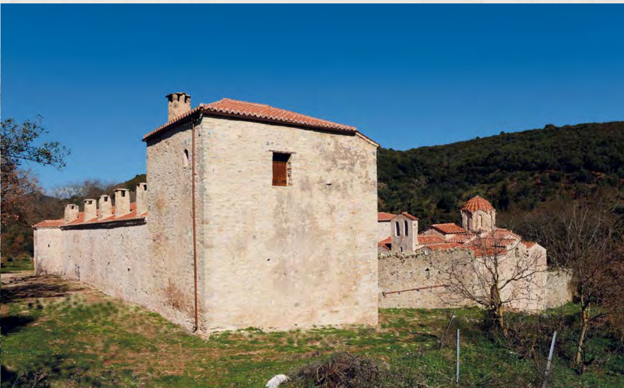
Νοτιοδυτικός πύργος. Άποψη από τα νοτιοδυτικά κατά τη διάρκεια και μετά την ολοκλήρωση των εργασιών αποκατάστασης The southwest tower. View from the southwest during and after the restoration
