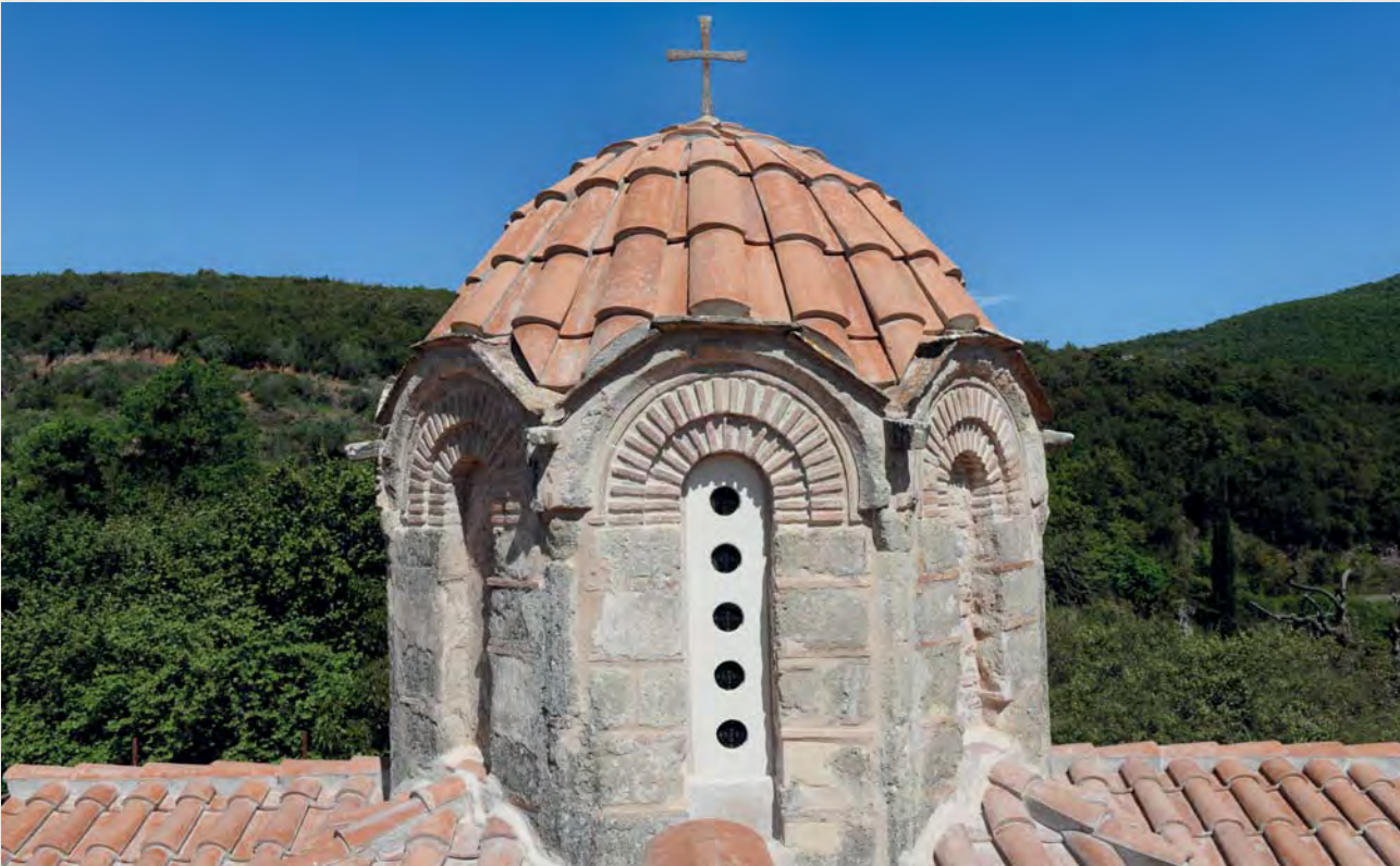
Άποψη του τρούλου πριν και μετά τις εργασίες αποκατάστασης The dome before and after the restoration
