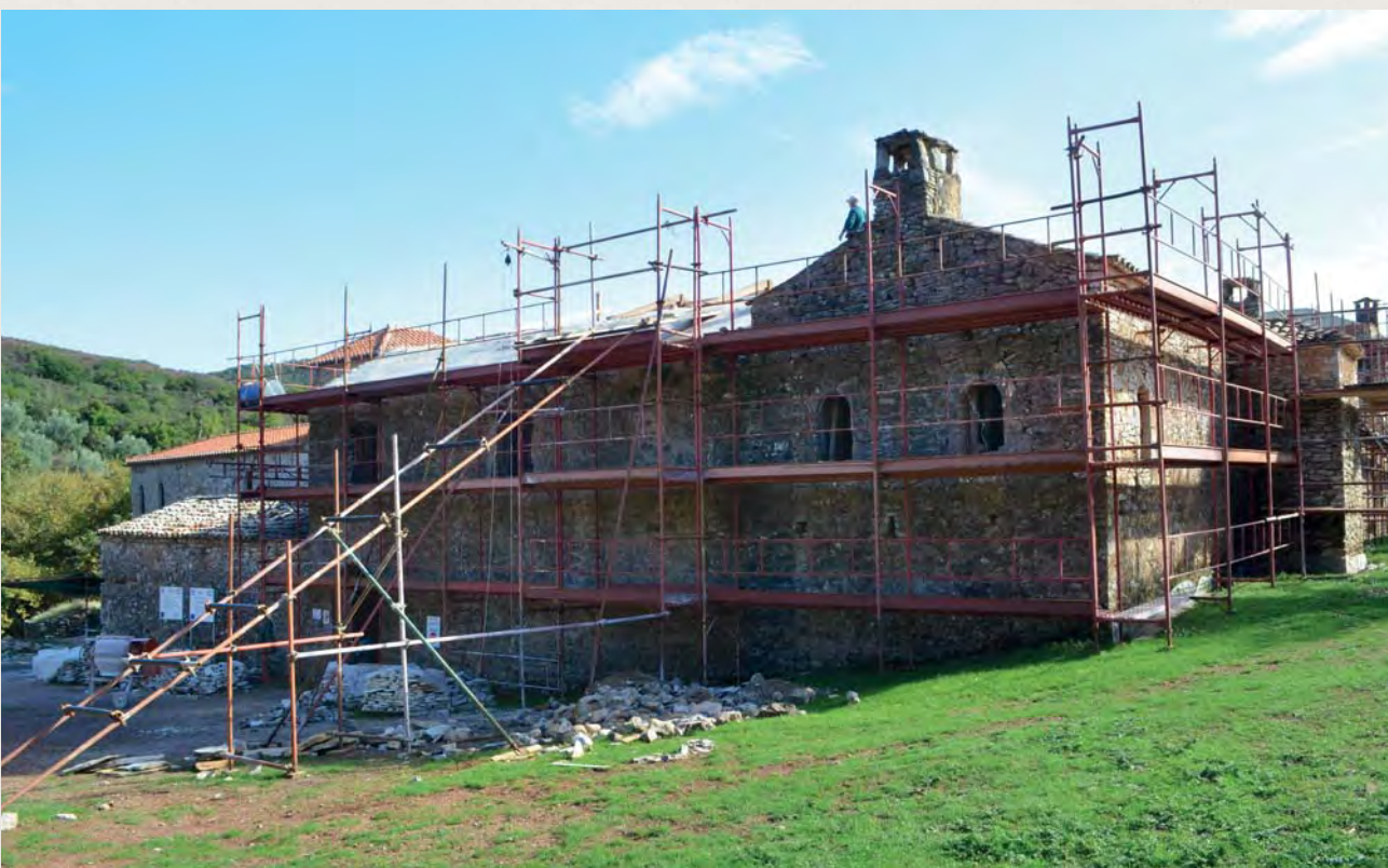
Άποψη της βορειοδυτικής και της δυτικής πτέρυγας πριν και κατά τη διάρκεια των εργασιών αποκατάστασης General view of the northwest and west wings before and during the restoration
