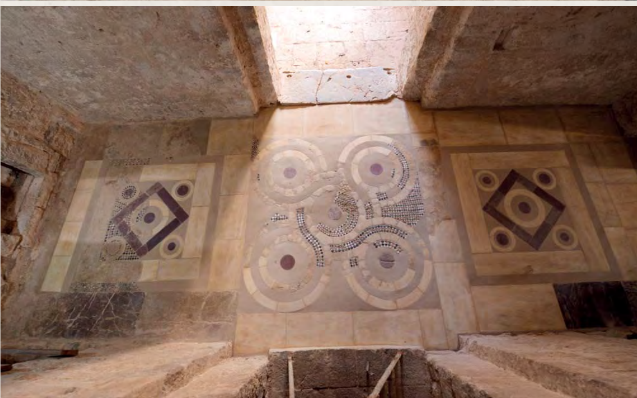
Το μαρμαροθέτημα του νάρθηκα κατά τη διάρκεια και μετά την ολοκλήρωση των εργασιών συντήρησης The opus sectile floor pavement of the narthex before and after the conservation
