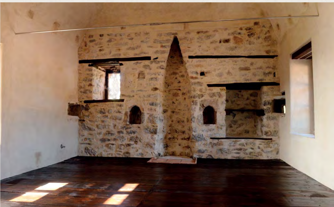
Νοτιοδυτικός πύργος. Εσωτερική άποψη του δωματίου της γ' στάθμης πριν και μετά την ολοκλήρωση των εργασιών Southwest tower. Interior view of the room at the third level before and after the restoration
