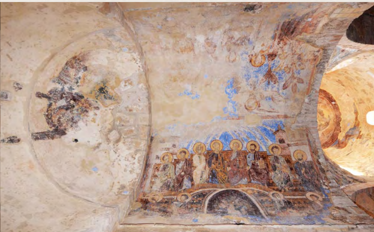
Άνοψη της καμάρας του ανατολικού σταυρικού σκέλους πριν και μετά τις εργασίες συντήρησης Interior view of the east barrel-vault before and after the conservation
