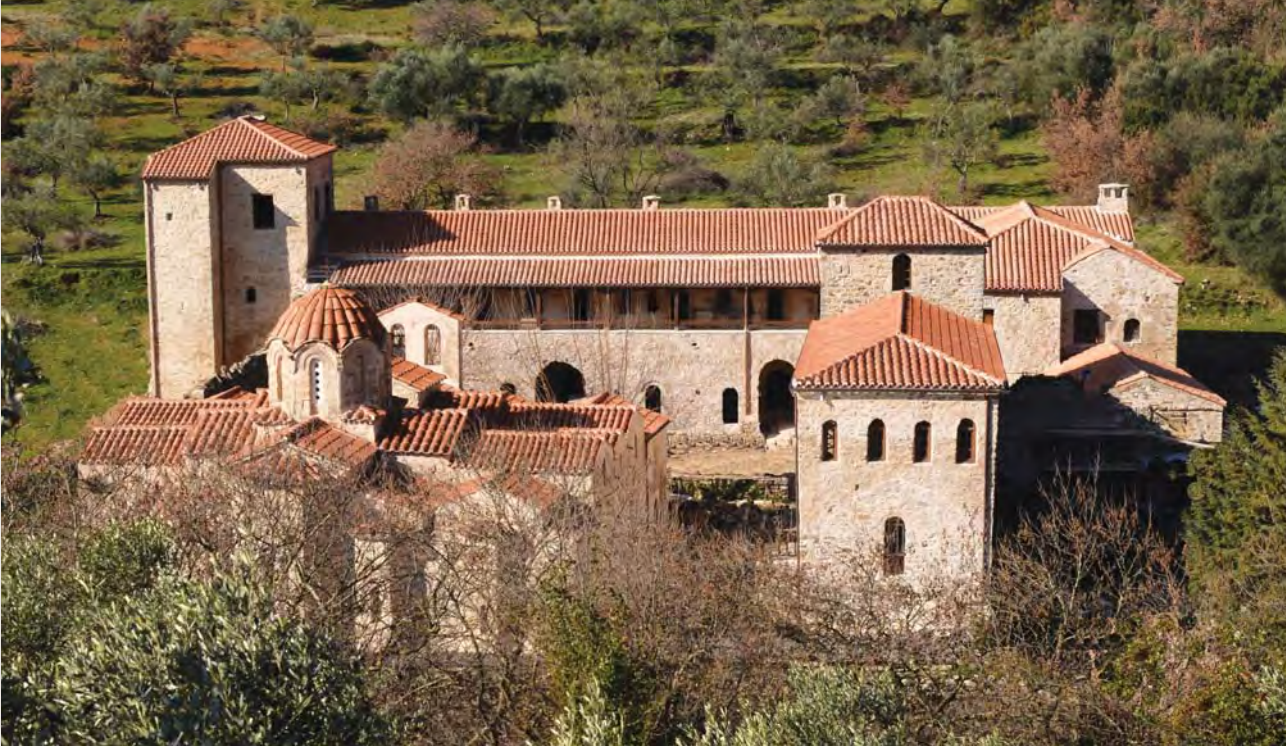
Γενική άποψη της μονής από τα ανατολικά μετά την ολοκλήρωση των εργασιών αποκατάστασης General view of the monastery from the east after the completion of the restoration
