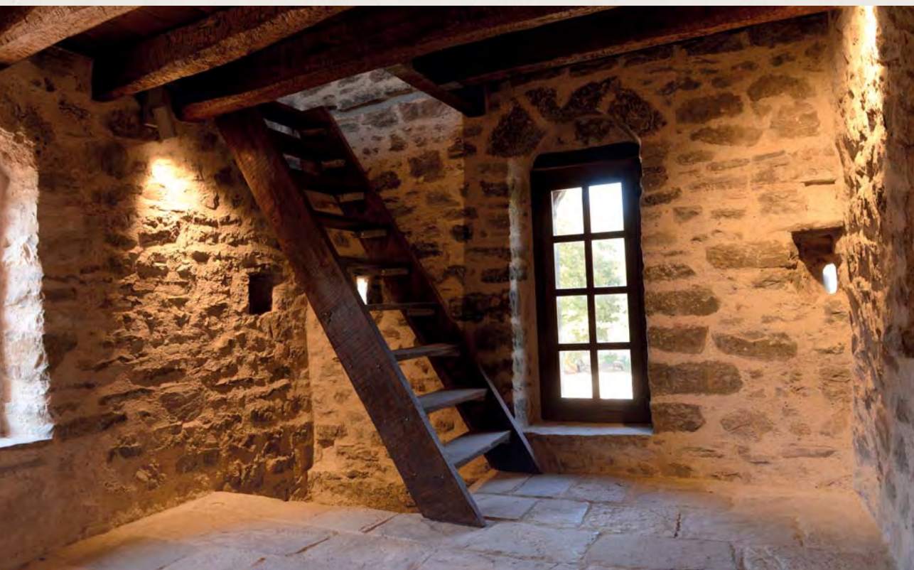
Απόψεις της τράπεζας και του βόρειου πύργου μετά την ολοκλήρωση των εργασιών Interior views of the refectory and the north tower after the restoration
