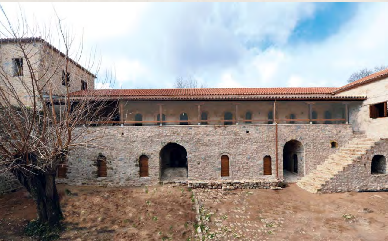
Ανατολική όψη της δυτικής πτέρυγας πριν και μετά την ολοκλήρωση των εργασιών The east facade of the west wing before and after the restoration
