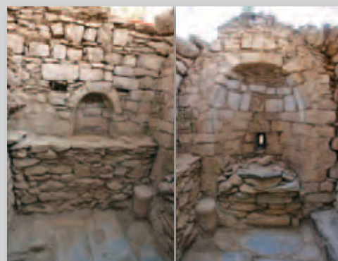
Πρόθεση και Αγία Τράπεζα. Πριν και μετά την αποκατάσταση.
