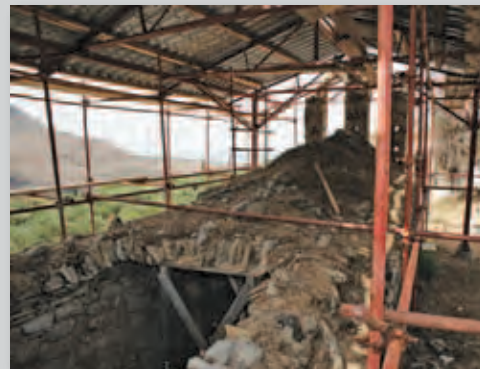
Ημικυλινδρική καμάρα -φουρνικά- στέγη Πριν, κατά τη διάρκεια και μετά την αποκατάσταση.
