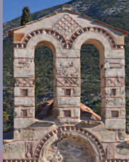
Το τοξωτό δίλοβο κωδωνοστάσιο πρίν και μετά την αποκατάσταση
