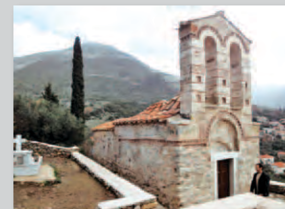
Βορειοδυτική όψη του ναού. Πριν και μετά την αποκατάσταση.
