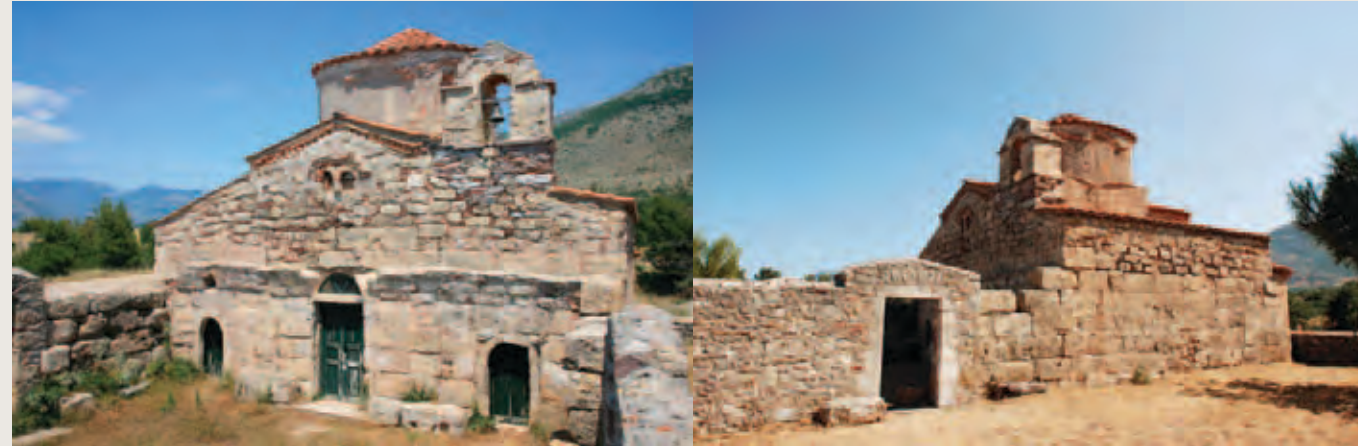
Δυτική όψη. Πριν από τις εργασίες West facade. Before restoration
